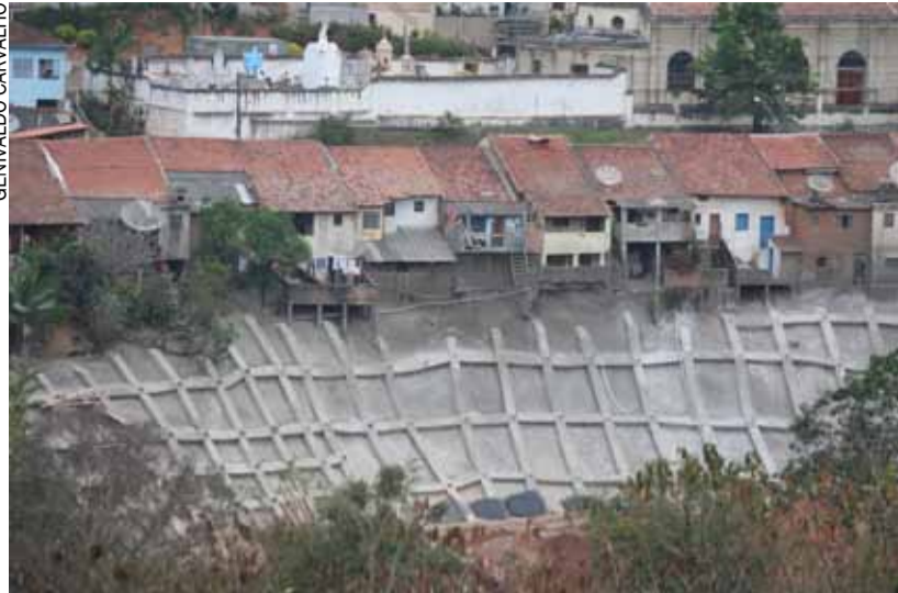
Imóveis da Rua do Carvalho já não correm risco após as obras
