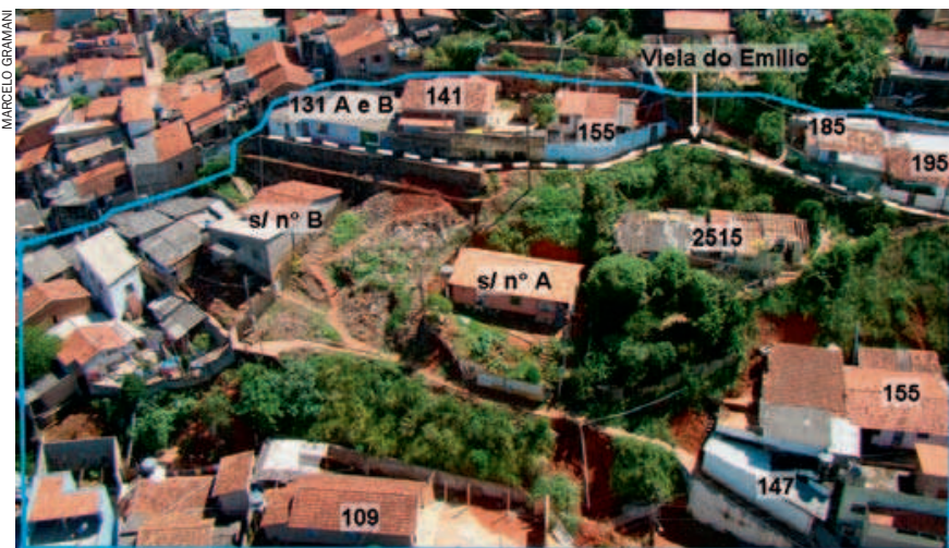
Todas as casas da cidade sujeitas a risco de desmoronamento já estão identificadas
