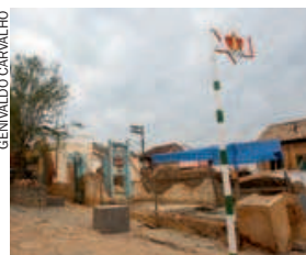
As ruínas da Capela das Mercês
