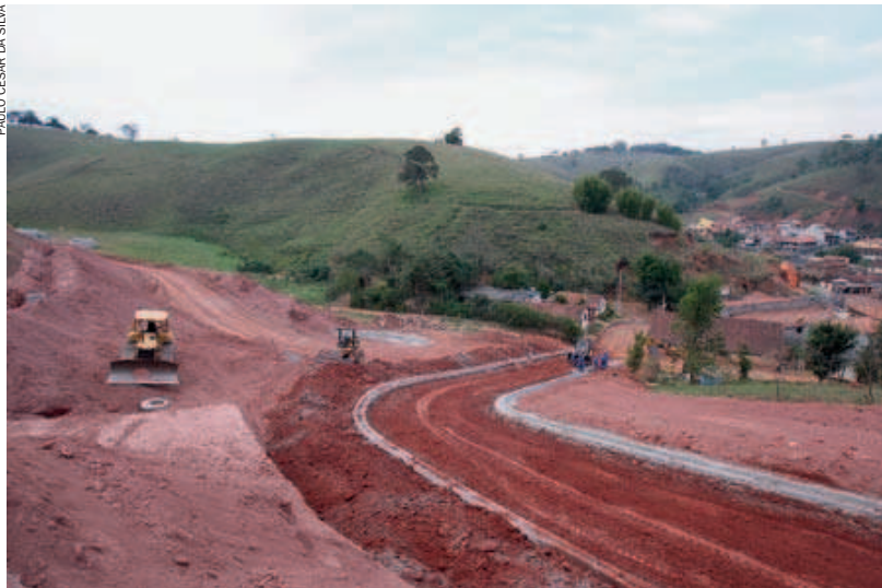
Obras de desassoreamento do Rio Paraitinga: abertura de ruas e construção de conjunto habitacional
