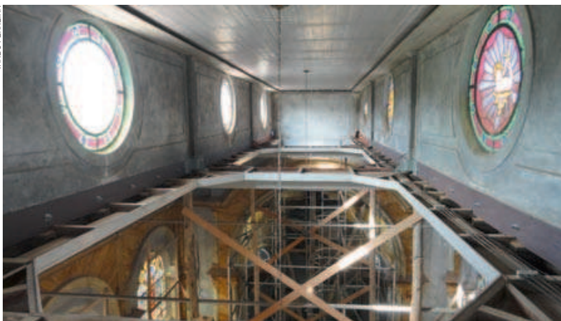
Reforço da nave central da Igreja N.S. do Rosário: obra do Instituto Elpídio dos Santos
