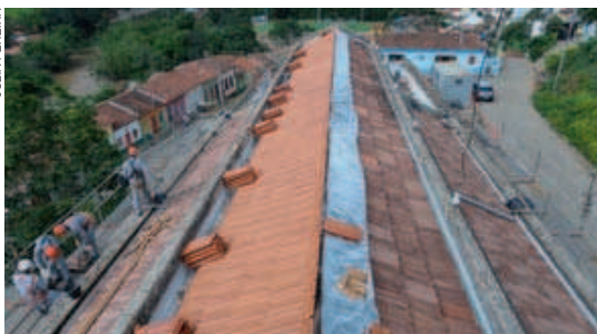
O telhado da igreja também já está praticamente recuperado
