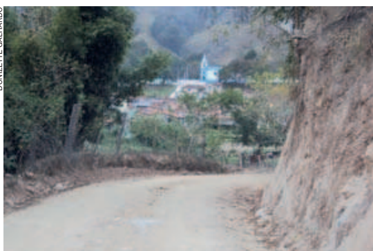
Recuperação de estradas rurais: investimentos passam de R$ 4 milhões
