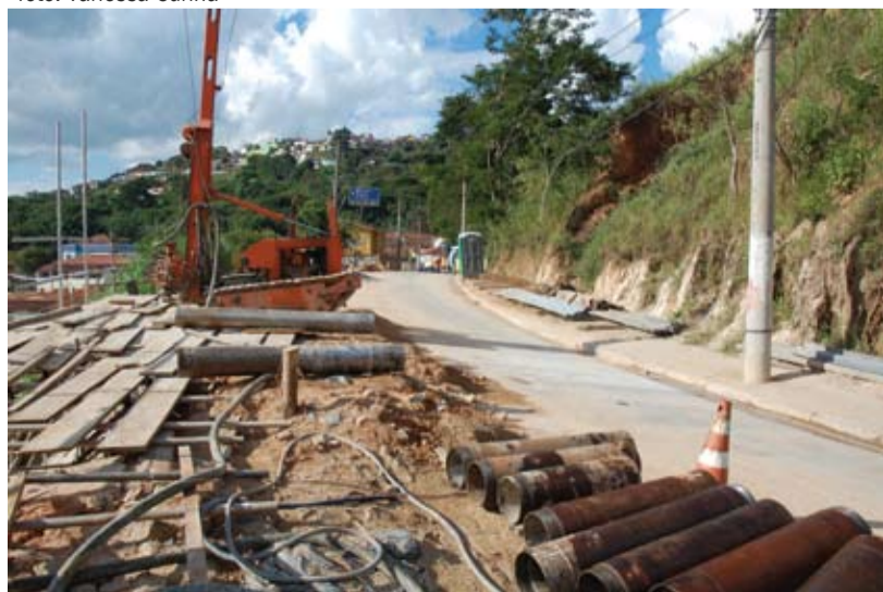
Obras de contenção às margens do Rio Paraitinga, na Várzea dos Passarinhos
