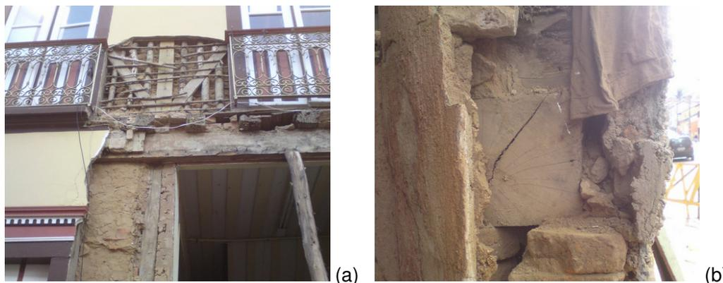
Figura 6 – Edificações em enxaimel com patologias pós-enchente: (a) moradia com fachada afetada pela força do rio, e, (b) detalhe estrutural de uma viga afetada em seu apoio com a alvenaria
