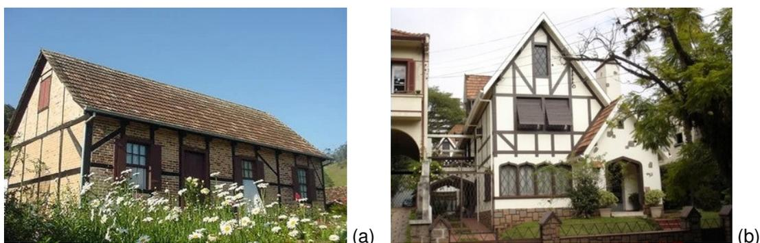
Figura 2 – Edificações em enxaimel de: (a) tijolo aparente [3], e, (b) fachada tipo alemã com reboco [4]
