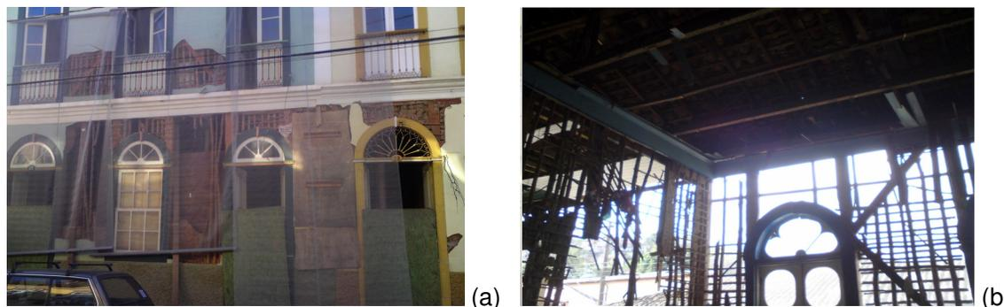
Figura 5 – Edificações em taipa-de-sopapo com patologias pós-enchente: (a) espaço comercial com a fachada afetada, e, (b) moradia com seu interior e fachada destruídos pela força do rio
