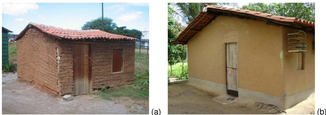
Figura 1 – Edificações de taipa-de-sopapo: (a) sem acabamento externo [1], e, (b) com acabamento fino para impermeabilização de seu fechamento contra penetração de insetos e roedores [2]
