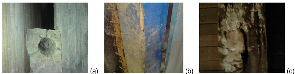
Figura 4 – Elementos construtivos que apresentaram patologias pré-enchente: (a) viga afetada por cupins, (b) pilar interno afetado por cupins, e, (c) pilar do barrote atacado por uma colônia de fungos e cupins
