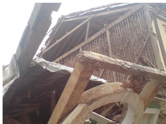
Figura 1 – Elementos estruturais de madeira parcialmente comprometidos devido a deterioração causada pelo ataque de insetos.
