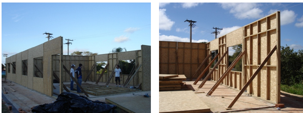
Figura 1a e 1b. Montagem das paredes portantes pré fabricadas
