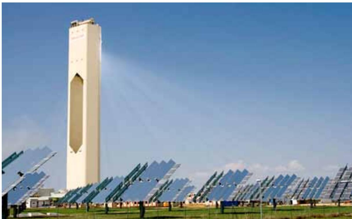
**Imagem 11:** Fazenda solar, com os painéis solares de captação focados para a torre (Local: Andalusia, Espanha).
