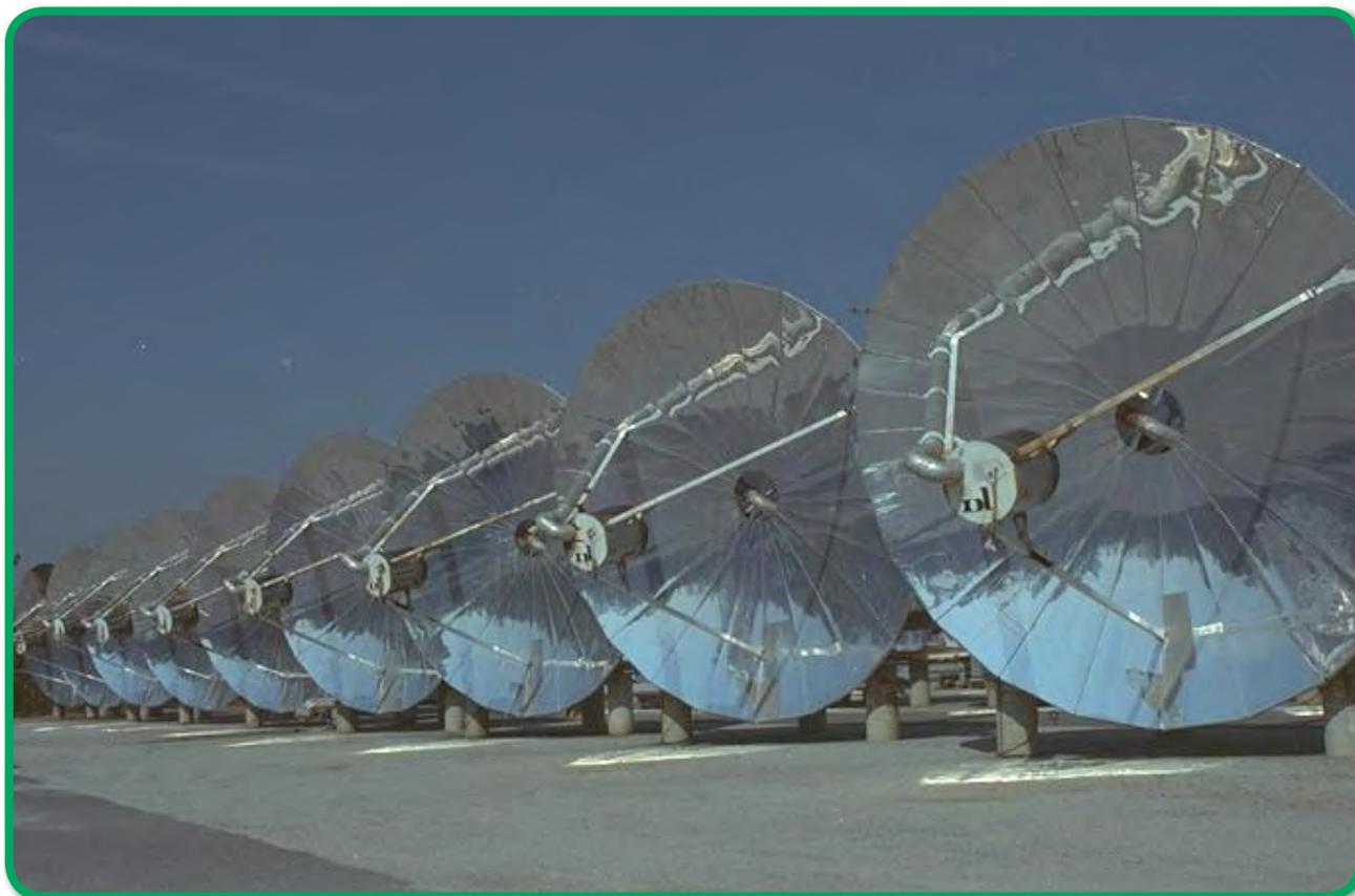
Figura 12: Conjunto de painéis solares de metal, com 7 metros de diâmetro e com sincronia pelo movimento do Sol (Local: Shenandoah, Geórgia, EUA).
