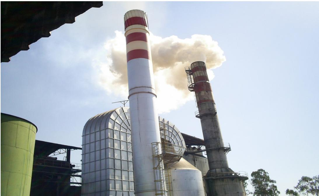
Imagem 27: Chaminés com emissões de gases e fuligem resultante da queima de bagaço de cana-de-açúcar.
