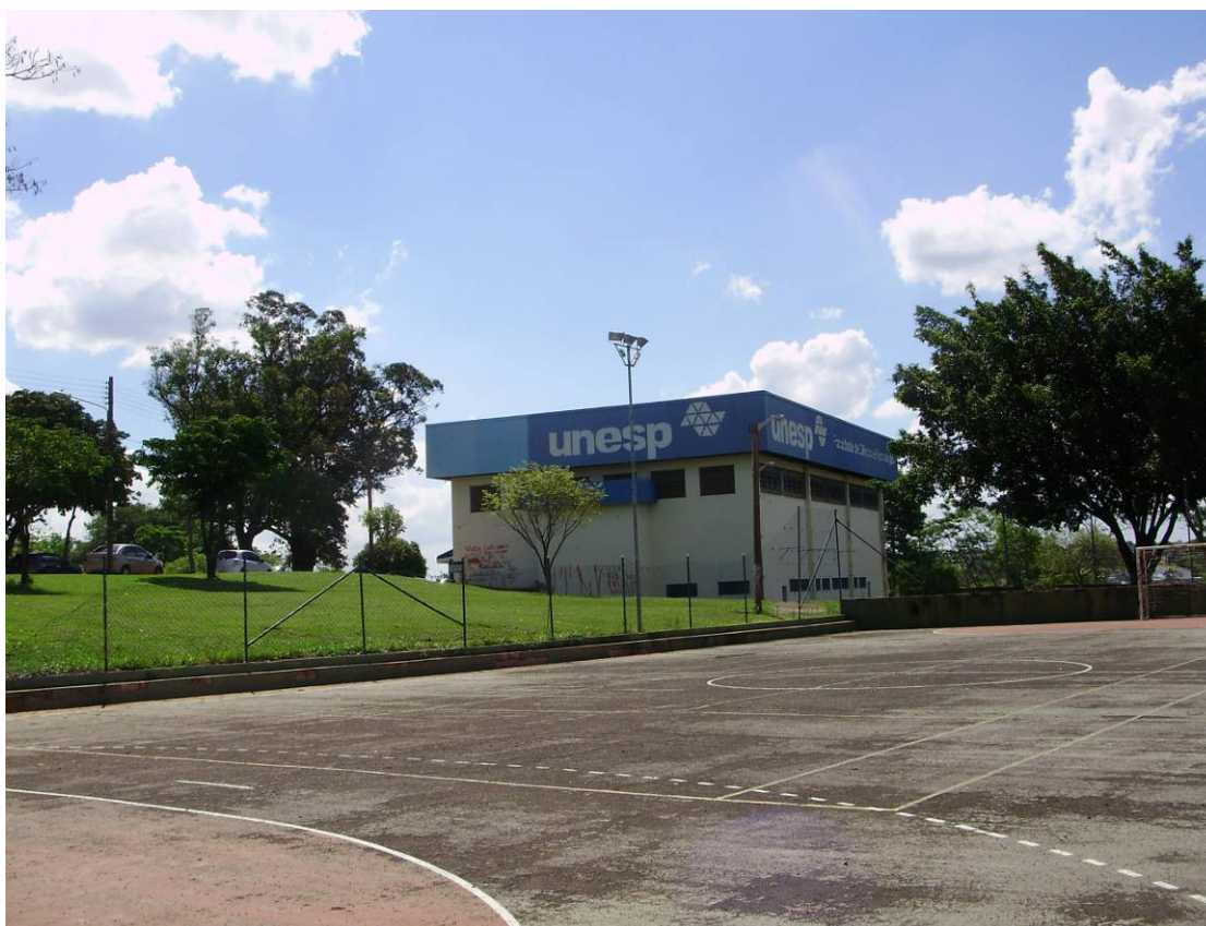
Figura 10- Visão panorâmica do Ginásio em 2015. Na atualidade existem novas construções, que alteraram este cenário. (Fonte: autoria própria)
