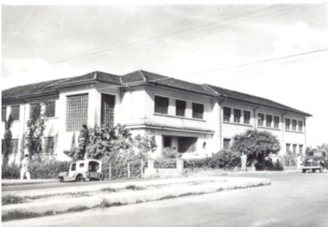
Figura 16 – Prédio que abrigou o primeiro Ginásio Estadual de Presidente Prudente e a Escola Normal Municipal, que posteriormente se tornou o Instituto de Educação Fernando Costa. Fonte: Museu e Arquivo Histórico, sem datação.
